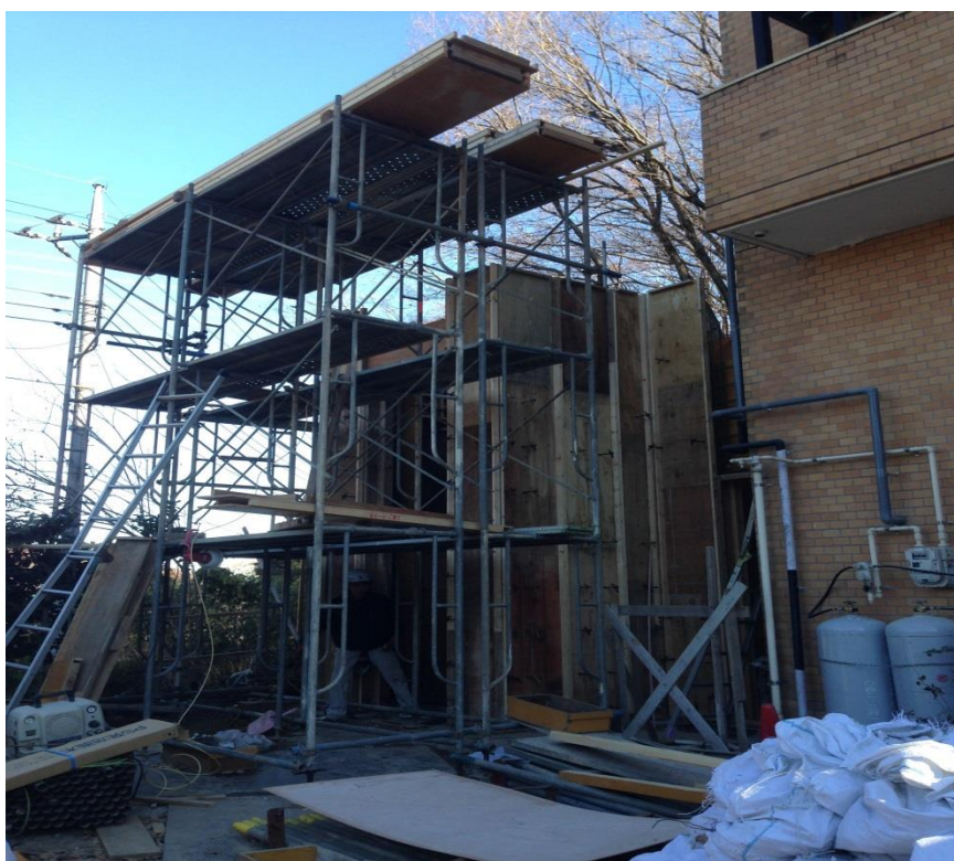
12月 地下1階鉄筋組み立て・型枠工事
